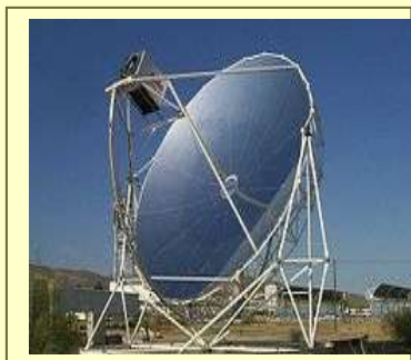
ΠΑΡΑΒΟΛΙΚΟΣ ΔΙΣΚΟΣ ΜΕ ΜΗΧΑΝΗ STERLING ΓΙΑ ΤΗ ΜΕΤΑΤΡΟΠΗ ΤΗΣ ΗΛΙΑΚΗΣ ΕΝΕΡΓΕΙΑΣ ΣΕ ΗΛΕΚΤΡΙΚΗ
