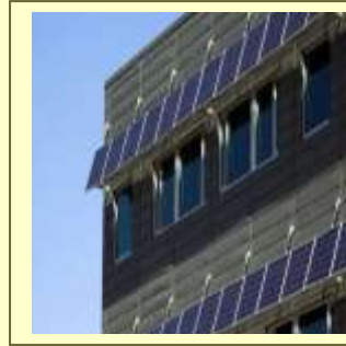
Φωτοβολταϊκά πλαίσια στη πρόσοψη κτιρίου
