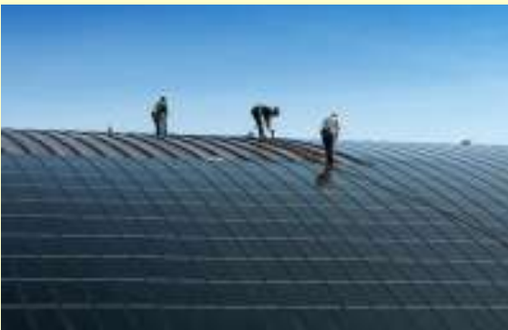
Φωτοβολταϊκά πλαίσια στη πρόσοψη κτιρίου
